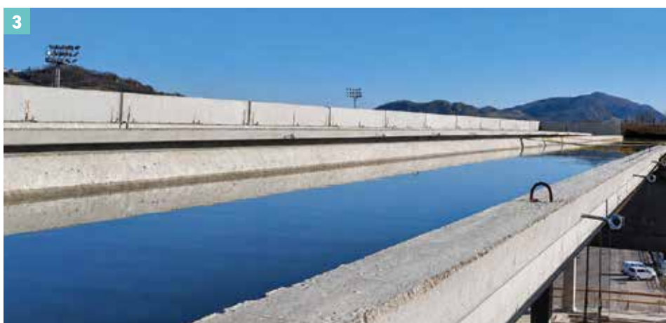
1. e 2. Prova di carico 3. Prova di carico con allagamento del canale
