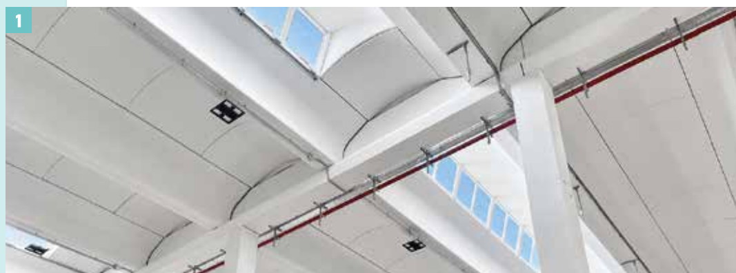
1. Copertura interna con FLY 130
