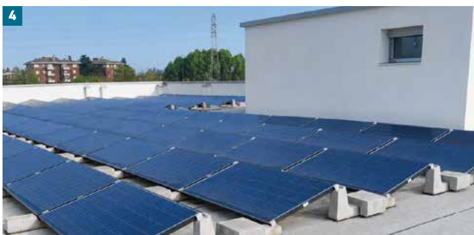
1. e 2. Montaggio copertura con NEW FLY Solaio 3. Stoccaggio del NEW FLY Solaio 4. Vista copertura con fotovoltaico
